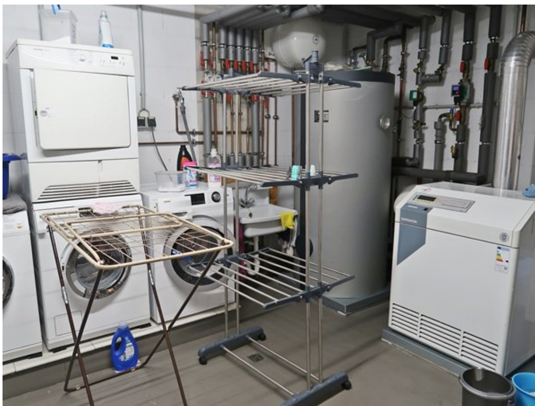
Waschküche mit Gasheizkessel, rechts, und Warmwasser-Standspeicher
