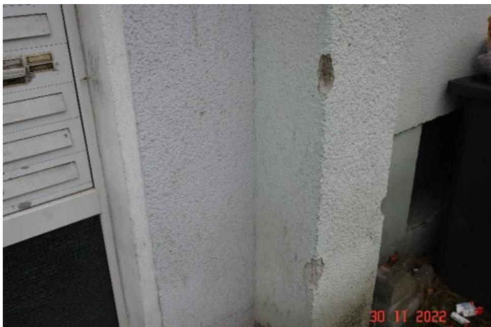
Bild 13: leichte Putzschäden an der Fassade
