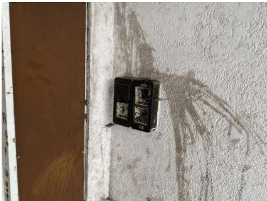
Bild 12: Beschädigte Klingelanlage
