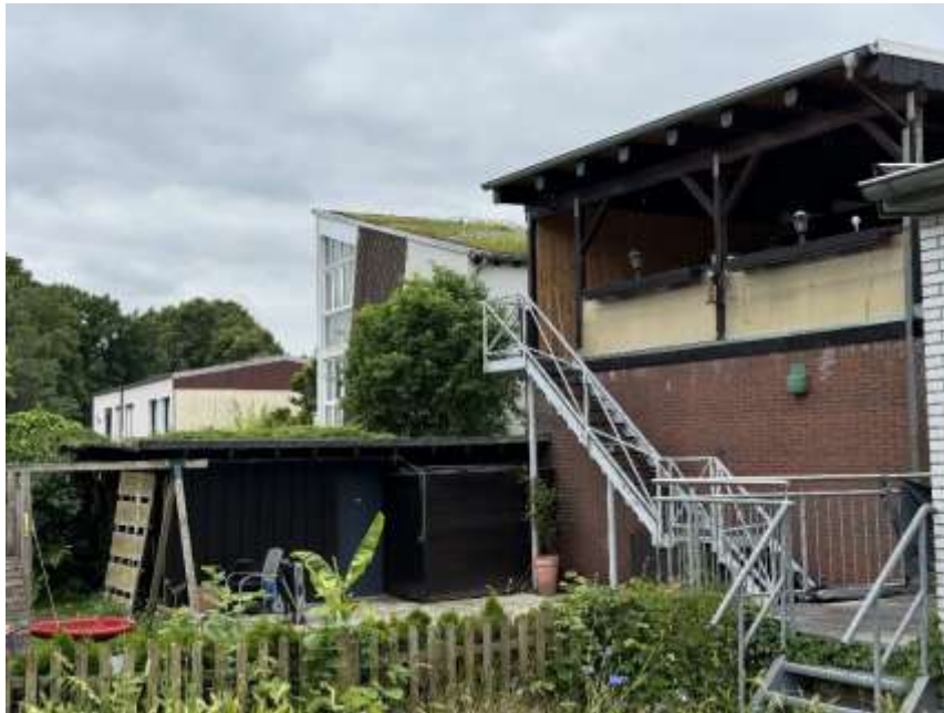
Bild 9: Ansicht auf den Garten des Bewertungsobjekts und Rückansicht des hintergelagerten Objekts der Blumenthalstraße 76
