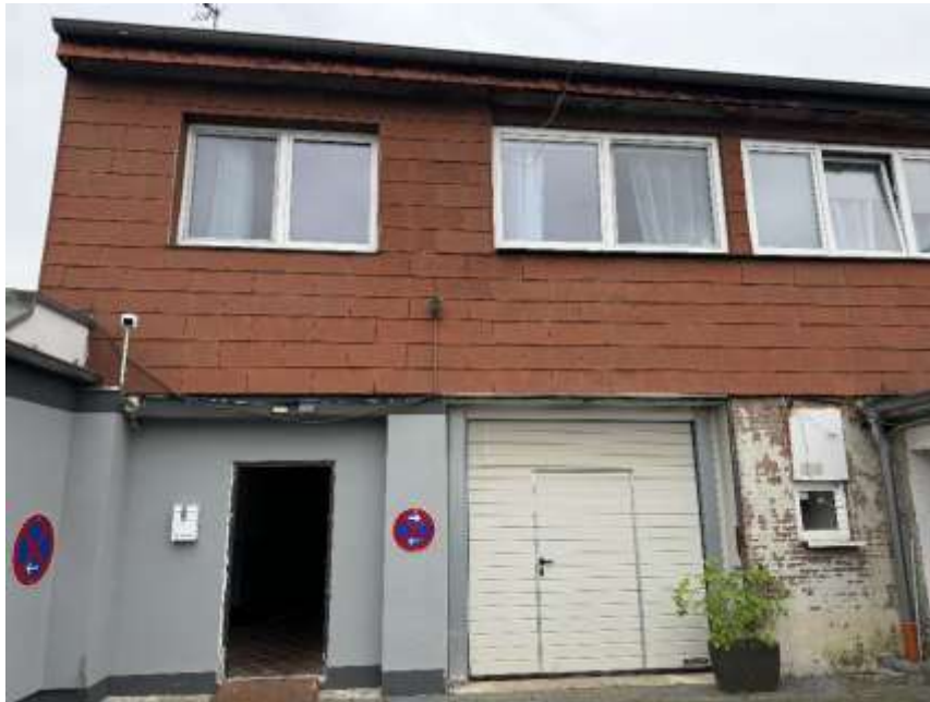
Bild 7: Ansicht Hintergebäude Blumenthalstraße 76
