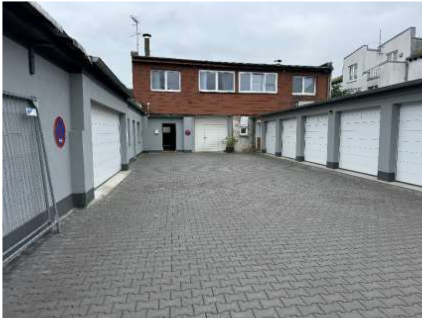
Bild 5: Ansicht auf Hintergebäude der Blumenthalstraße 76
