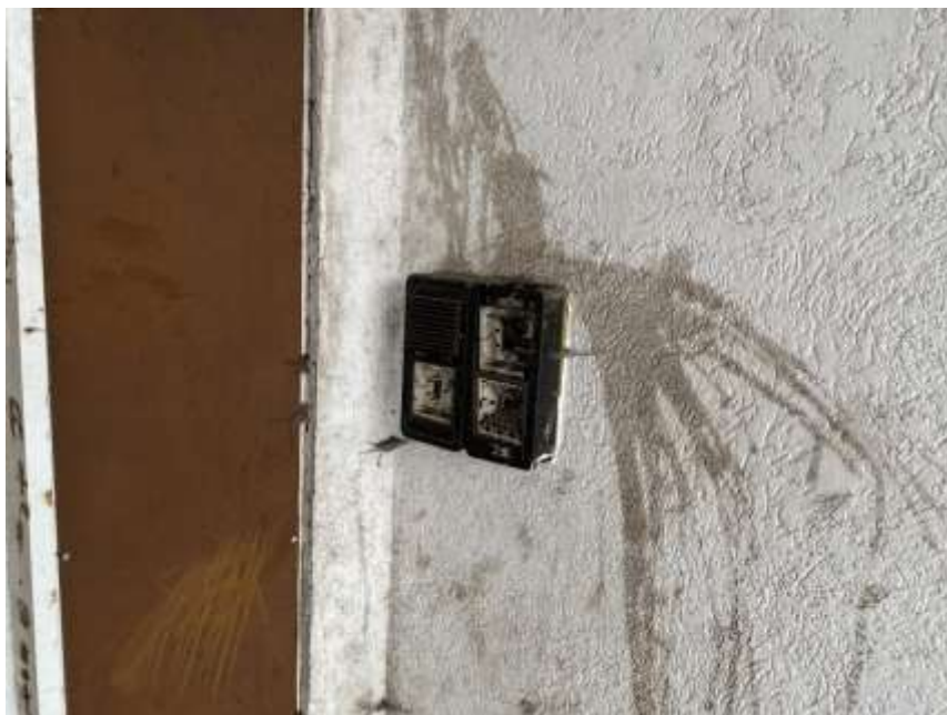
Bild 12: Beschädigte Klingelanlage
