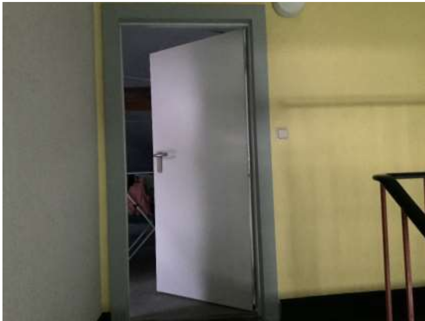
Bild 12: Zugang zum DG mit Abstellräumen im SE
