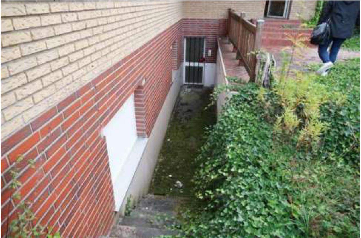
Fehlende Klinkersteine links, Putzschäden rechts im Bild
