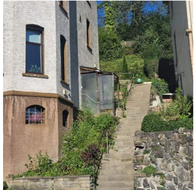
Abb. 2: Seitliche Treppe, Blick von unten
