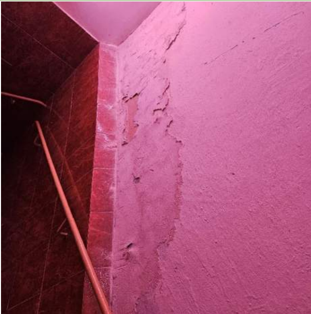
Abb. 13: Feuchtigkeitsschaden Kellerabgang
