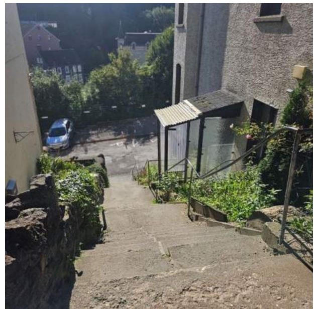
Abb. 4: Seitliche Treppe, Blick von oben
