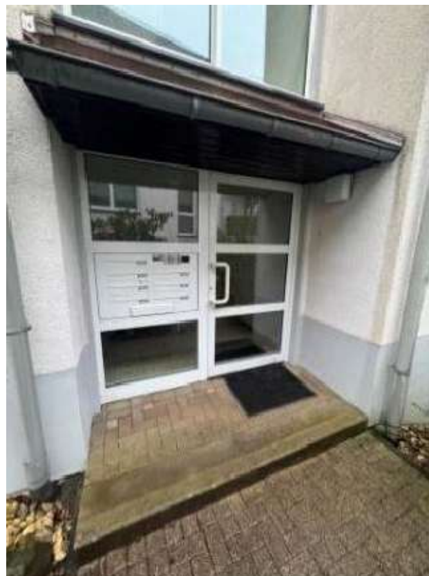
4. Foto Ansicht Hauseingang Un- terbraker Weg 39
