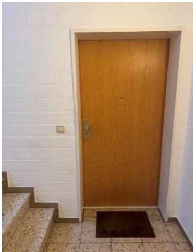
6. Foto Ansicht Eingang WE 10
