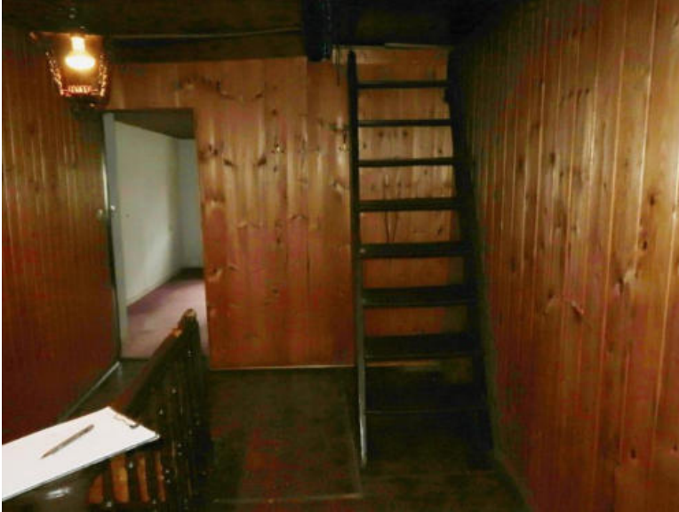
Flur mit Treppe zum Dachgeschoss
