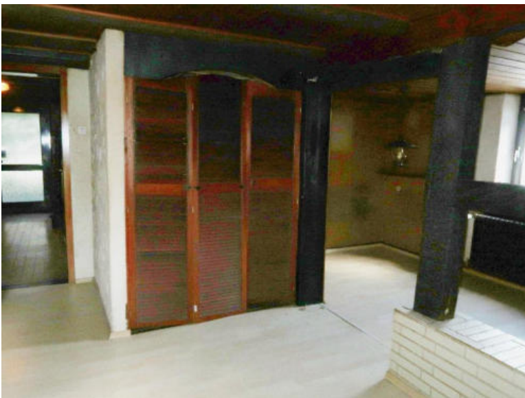
Lamellentür zum Abstellraum
