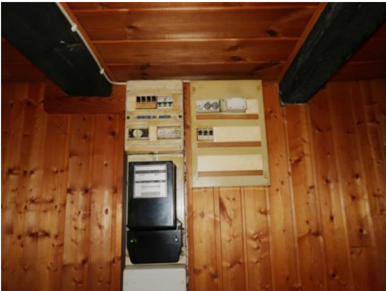
Zählertafel, Unterverteilung
