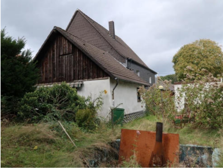
Ansicht Süden, im Vordergrund der ursprünglich als Stallgebäude errichtete, heute wohnlich genutzte Anbau.
