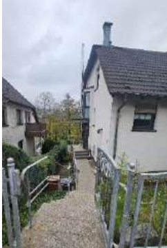
Foto 1: Zugang zum Gebäude
