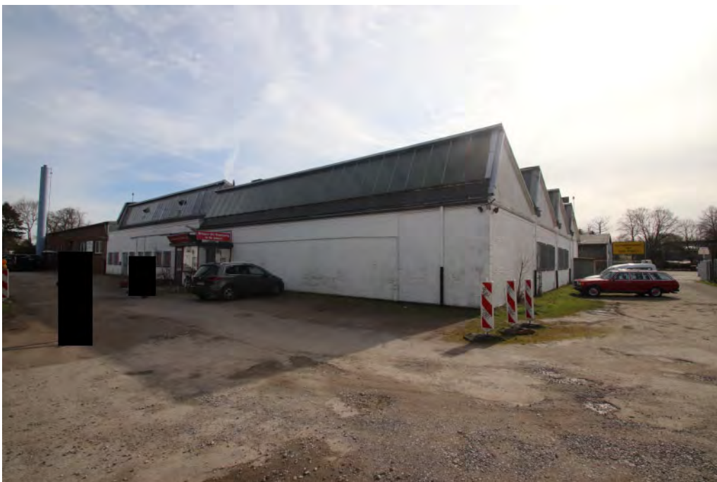
Gewerbebehalle (Bauteil A)
