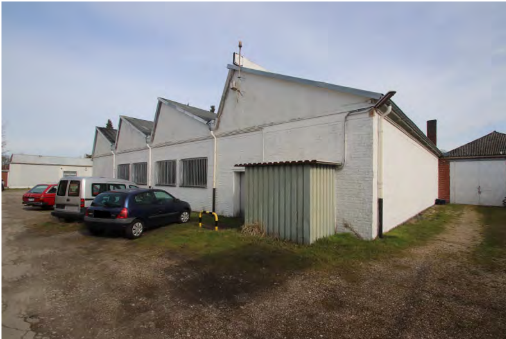
Gewerbehalle (Bauteil A) mit Erweiterung
