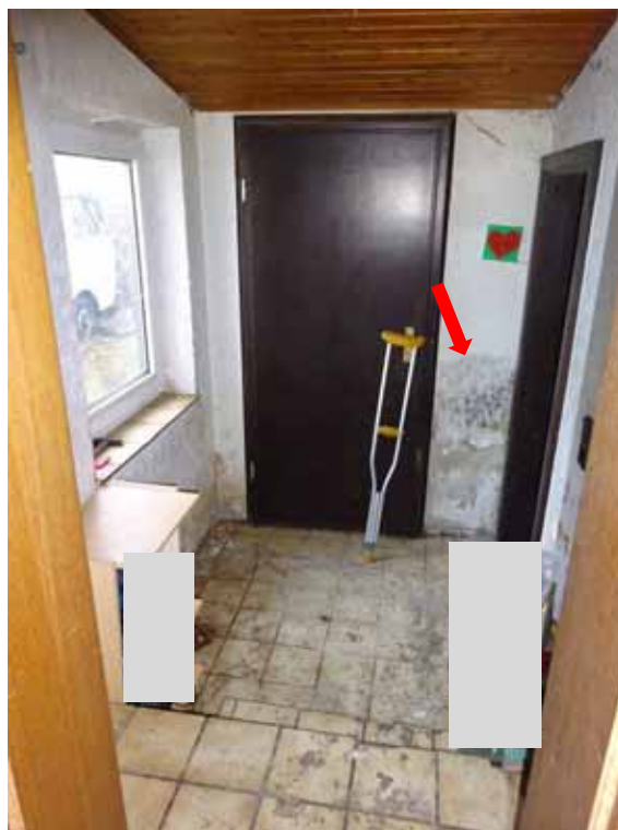
Vorraum Anbau mit Zugang Bad (aufsteigende Feuchte an Wänden)
