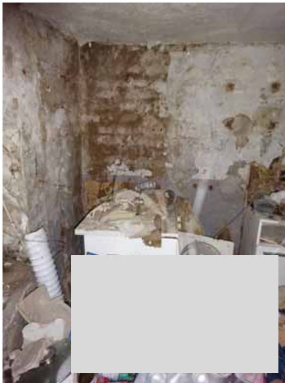
Waschküche Anbau / erhebliche Feuchteschäden
