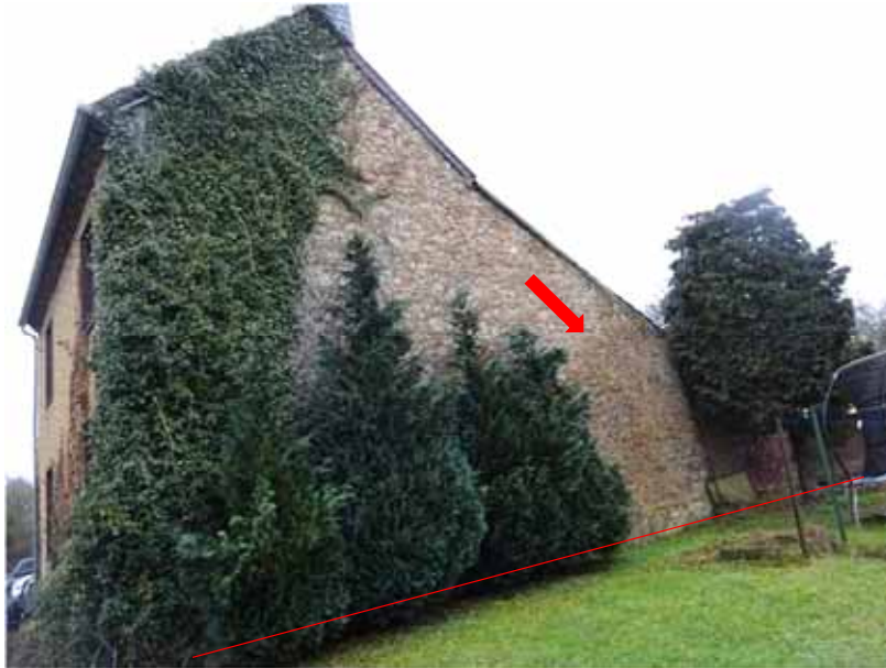
Giebelseite Ost, Feuchte in Mauerwerk
