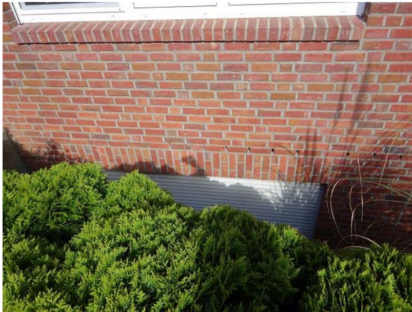
Vorgarten mit Lichtschacht
