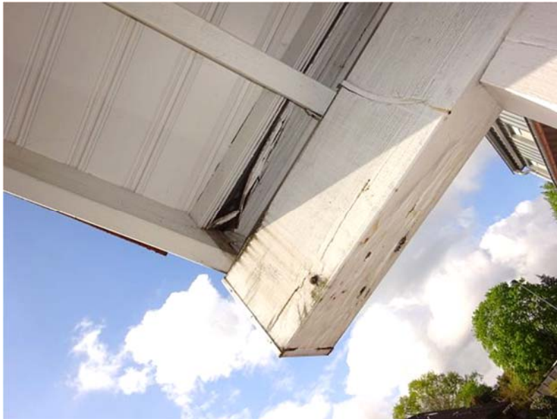
Traufpunkt schadhafter Sparren / Carport
