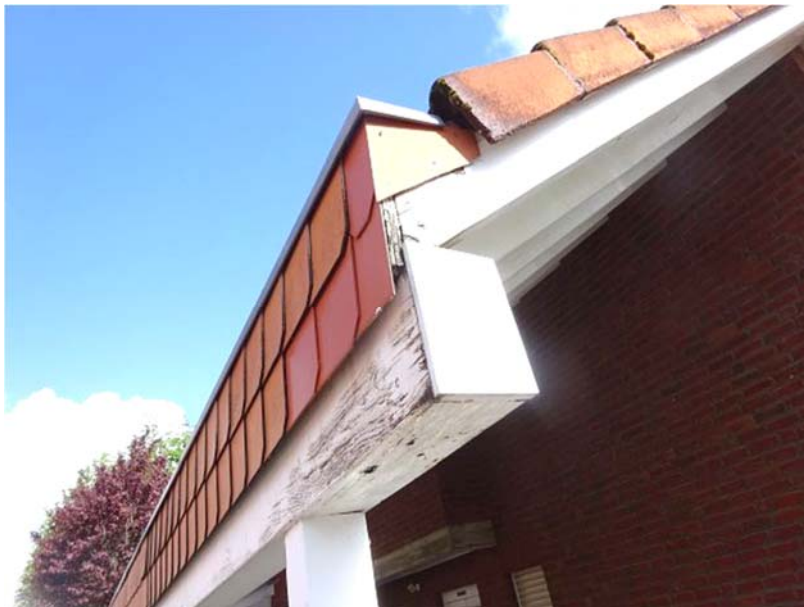
Anschluss Sparren / Balken
