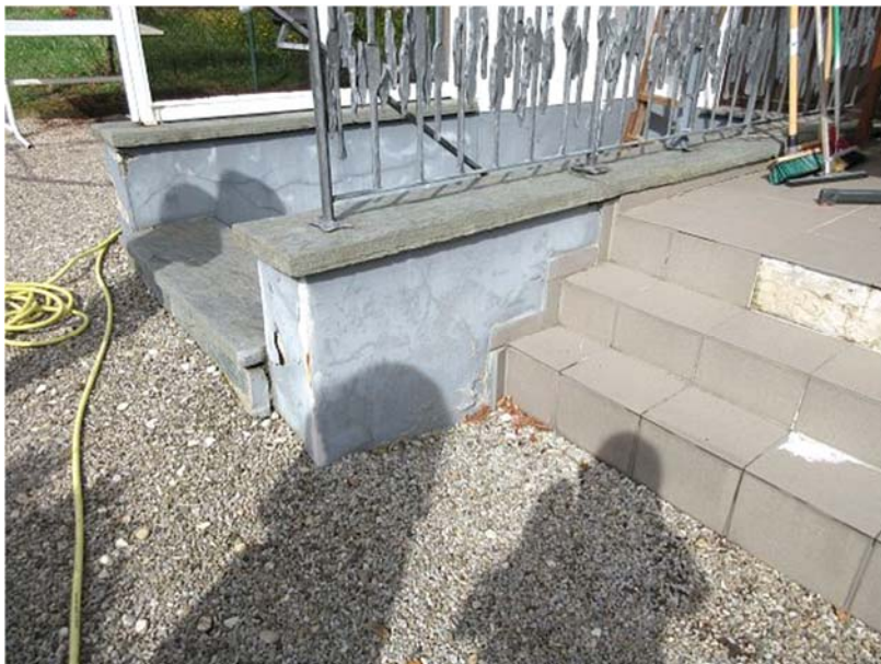
Feuchteschäden Außentreppen
