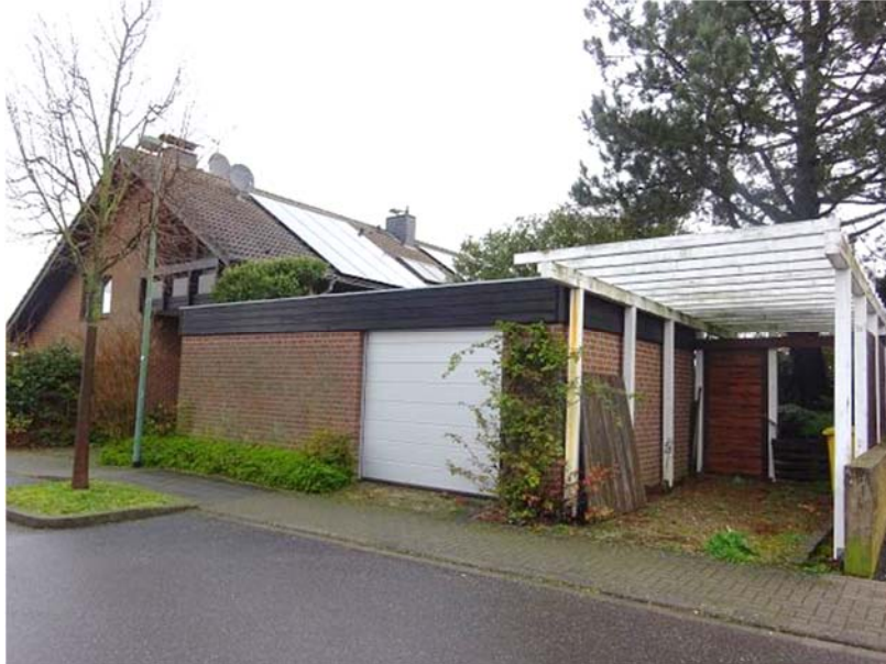
Straßenansicht Hastenrather Fließ
