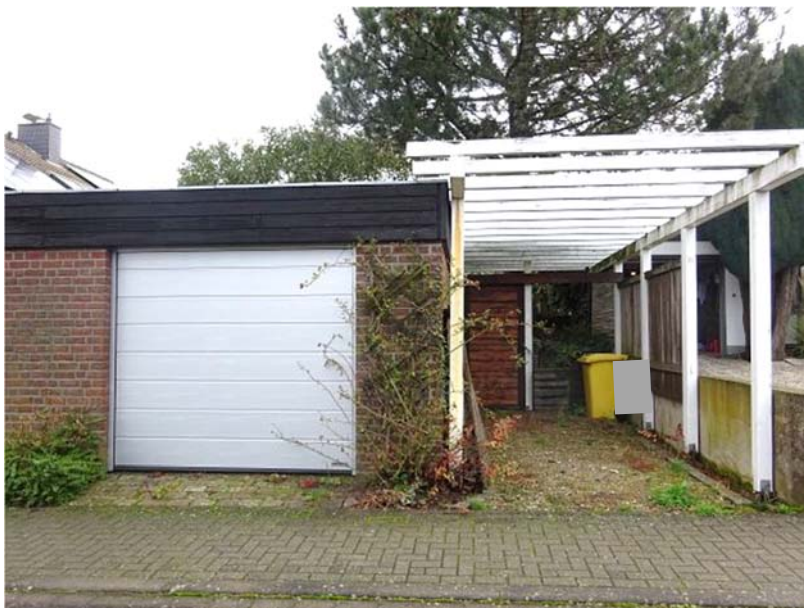
Carport und Garage seitliches Tor
