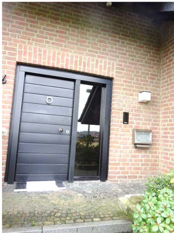
Eingang Hauptwohnung (Hausnr. 26)
