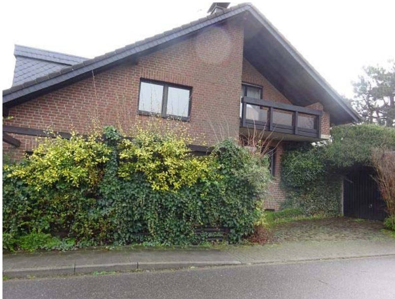
Straßenansicht Hastenrather Fließ (Wohnhaus)
