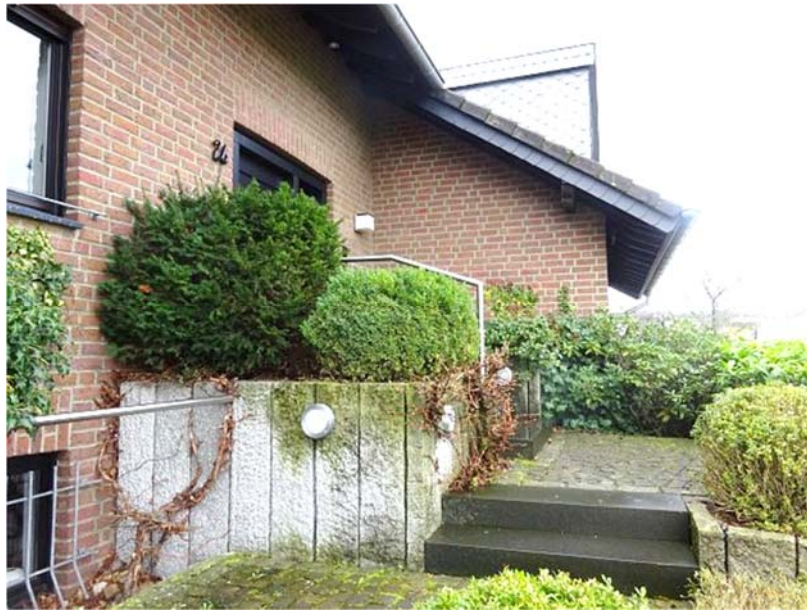
Außentreppe Eingangsbereich Hauptwohnung
