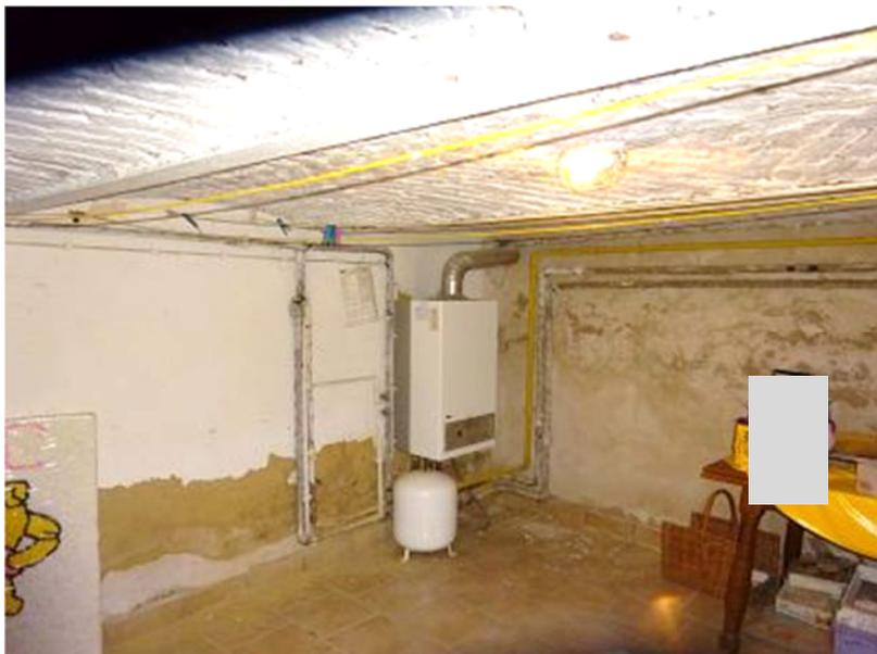
Keller mit Heizung (Feuchteschäden)
