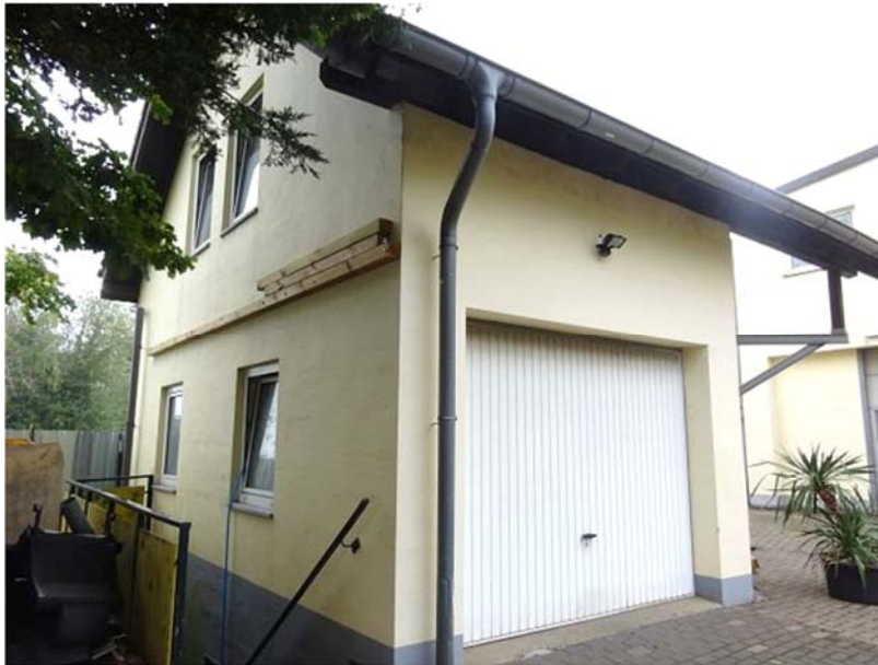
Lager- und Garagengebäude mit SE Nr. 4
