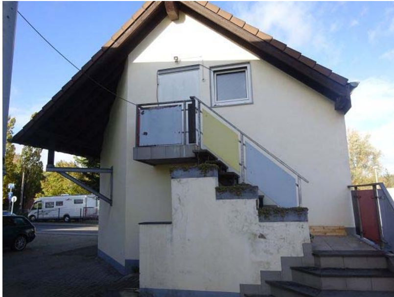
Seitenansicht Lagergebäude mit Außentreppe zu DG
