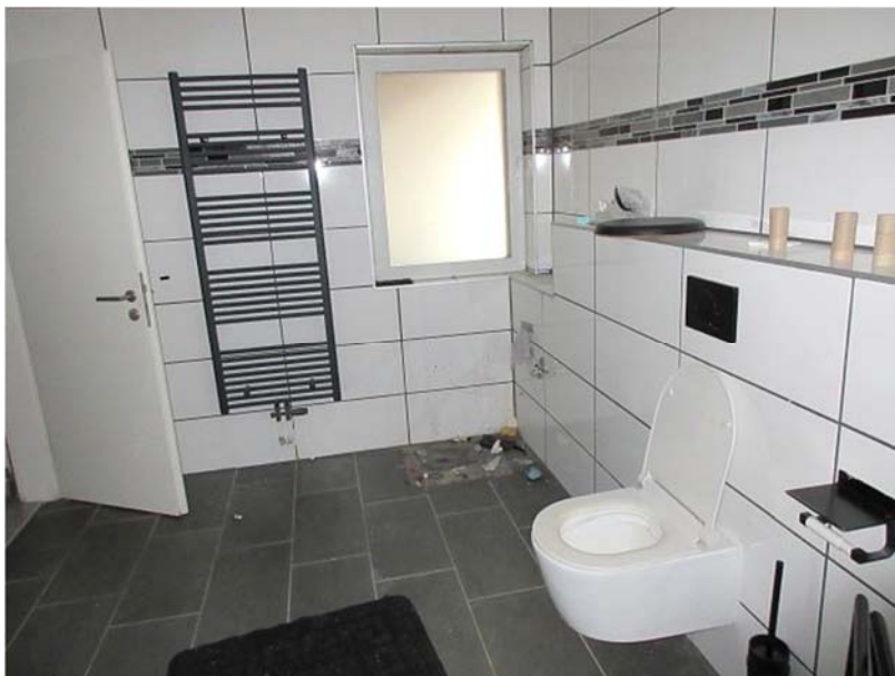
Bad mit Fenster zum unfertigen Anbau
