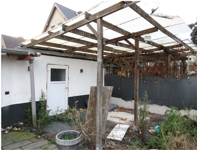
Gartenansicht Garage und Überdachung
