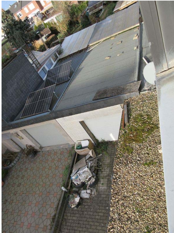
Blick auf Einfahrt, Garagen- und Anbaudach
