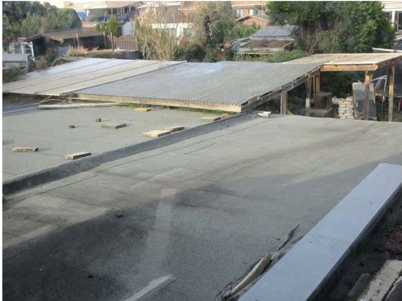
Garagen- und Anbaudach, hinten Holzüberdachungen
