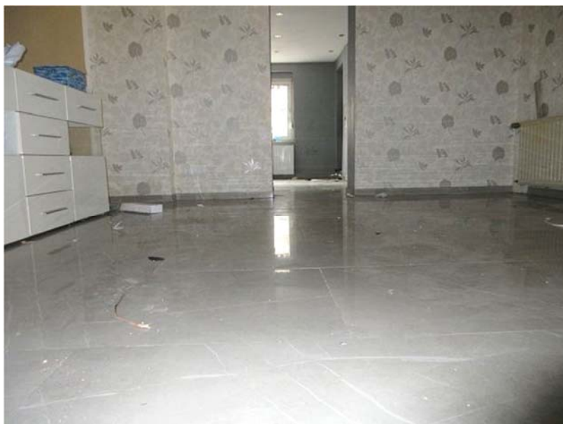
Bodenbelag mit Gefälle, Plattierung mit Versatz
