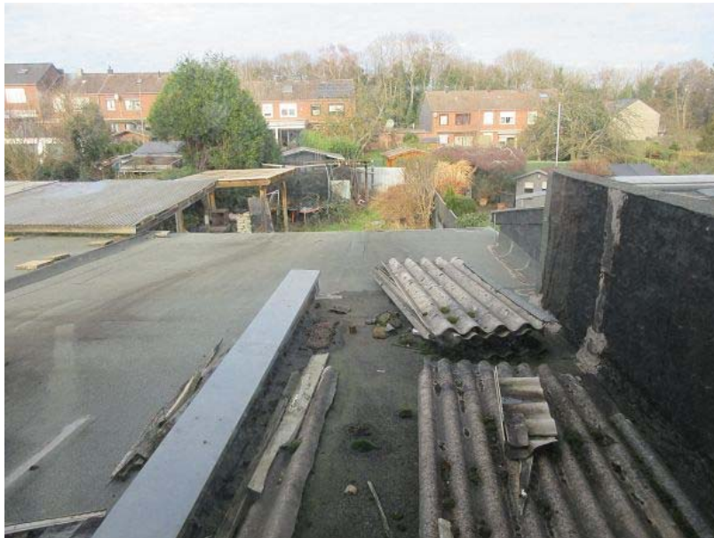
Anbaudach alter Bereich
