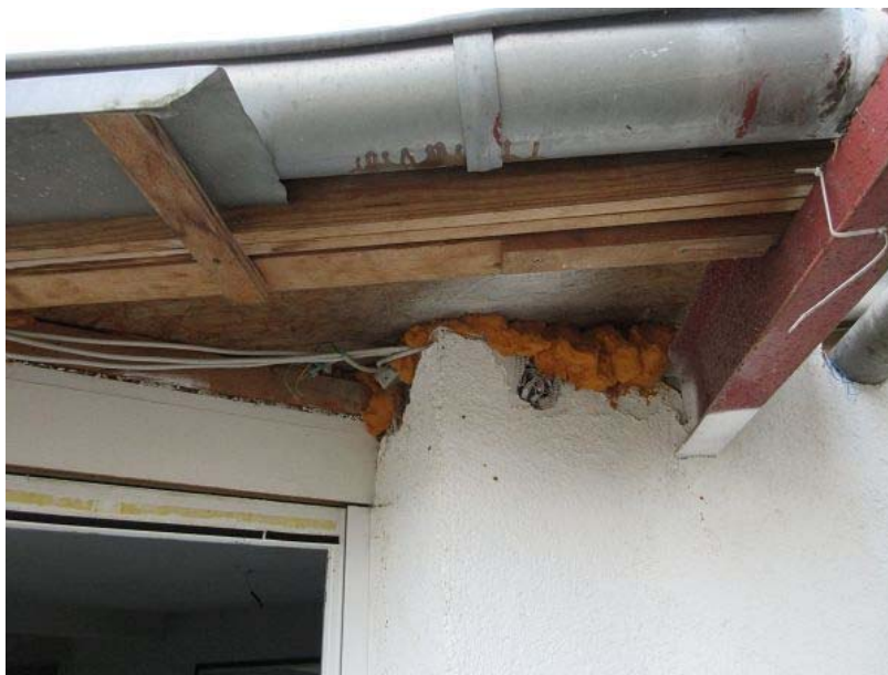
Anschlussstelle Anbaudach / Außenwand
