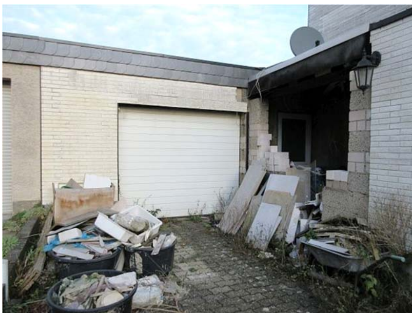
Garagenfont, Einfahrt und Anbaubereich in Rohbau
