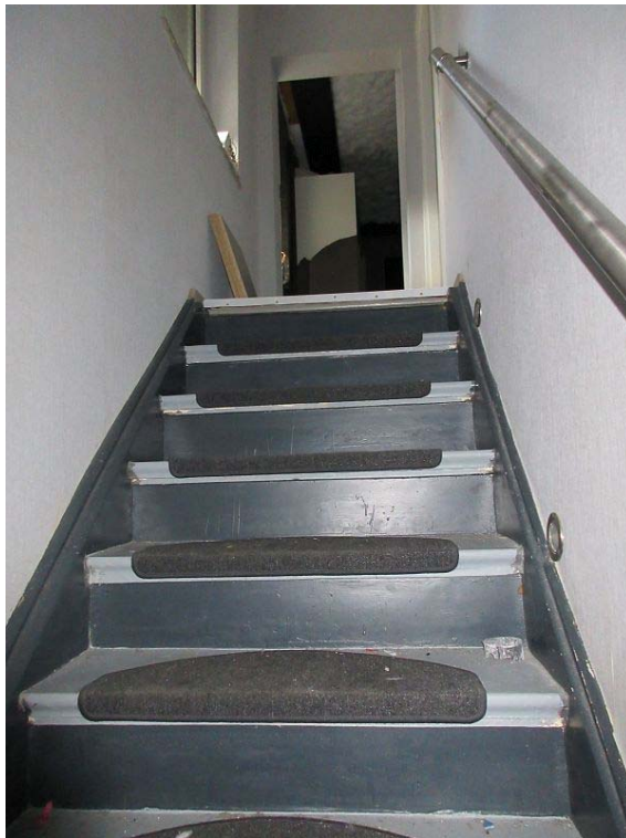
Geschosstreppe zu OG
