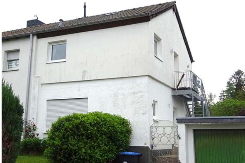
Anbau EG mit Aufstockung OG/DG
