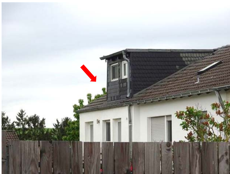
Gartenansicht Ober- und Dachgeschoss / Gaube zu ETW Nr. 2
