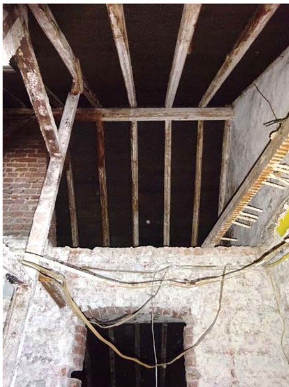
Blick in den Dachstuhl vom Treppenhaus aus
