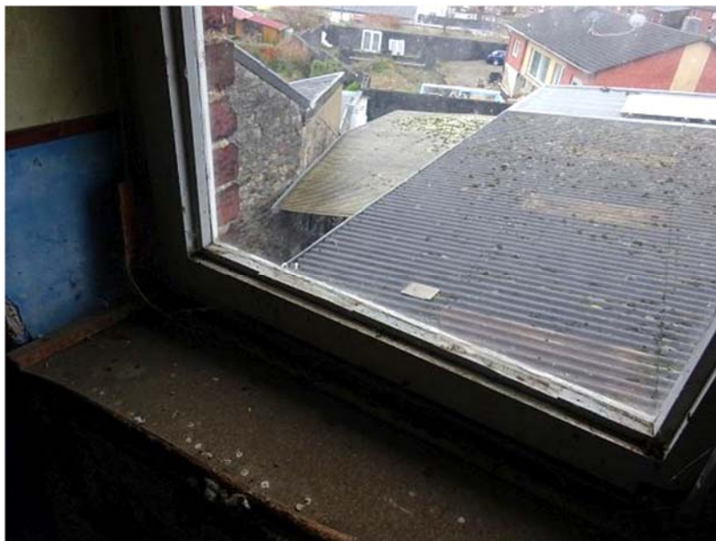
Blick auf Anbau- / Hallendach und Hofüberdachung
