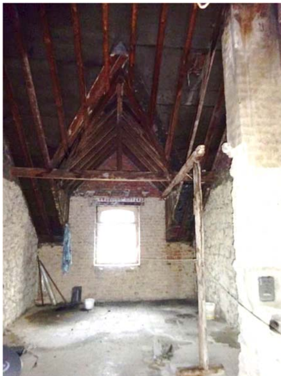
DG – Innenwände entfernt
