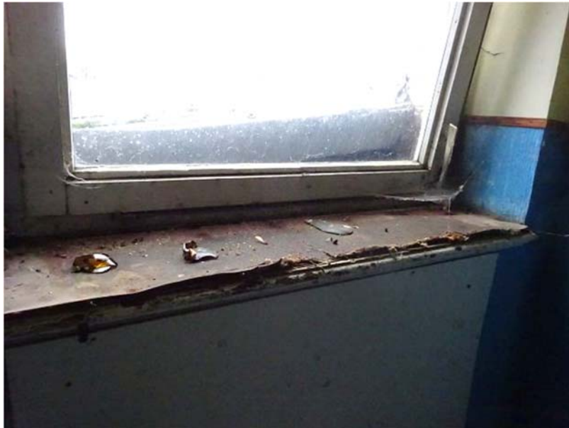
Detail Fenster und Fensterbank innen
