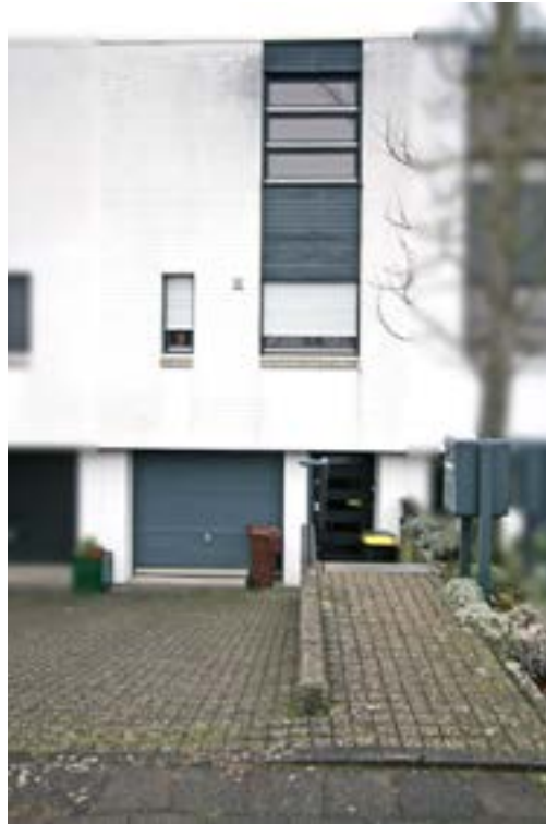
Bild 3: Straßenansicht des Bewertungsobjekts aus südöstlicher Richtung
