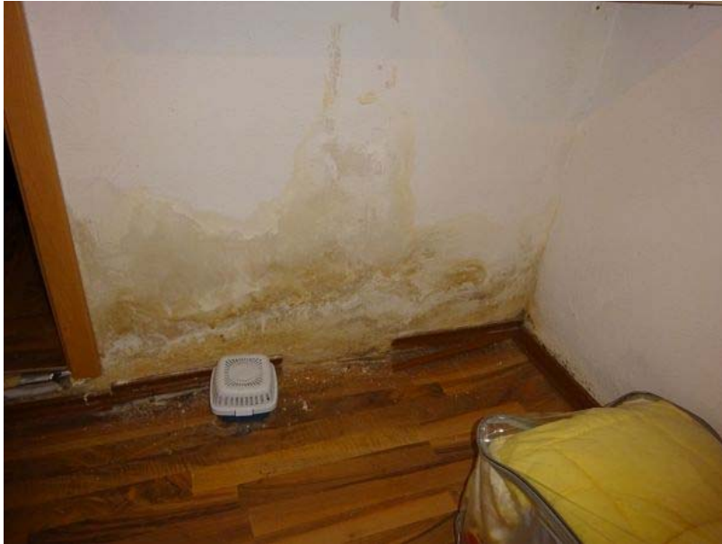
Feuchteschäden Anbau KG
