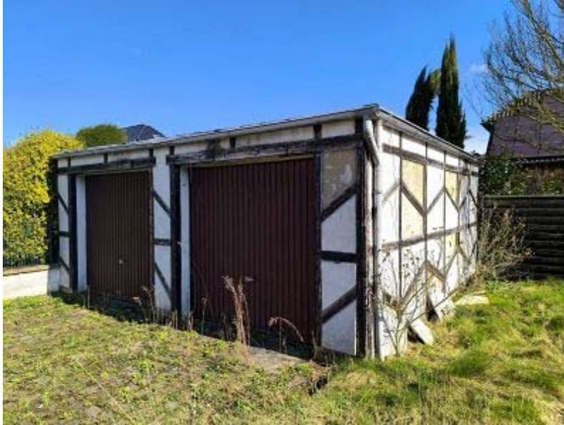
Doppelgarage (Feuchteschäden)
