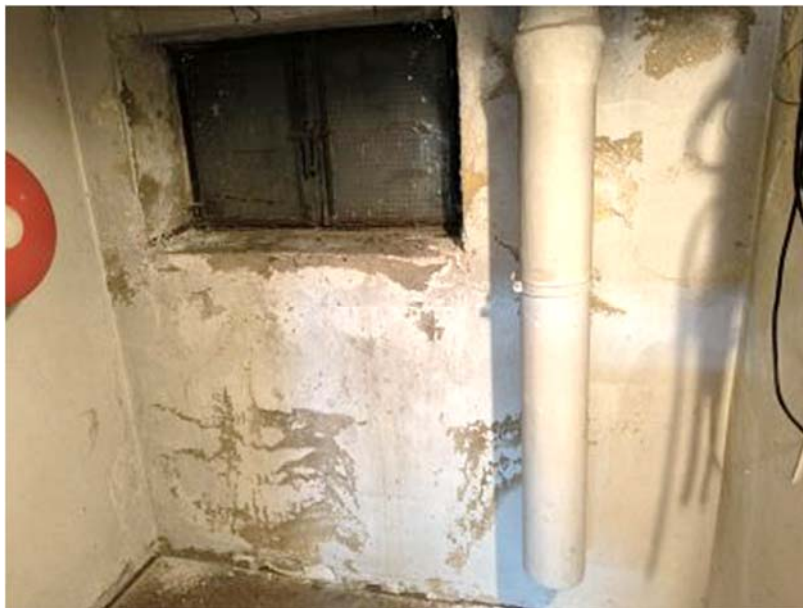
Feuchteschäden Außenwände
