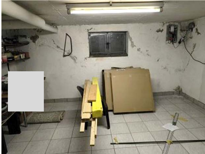
Keller - Feuchteschäden
