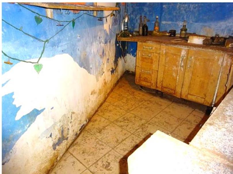
Schimmelbildung an Außenwänden, Boden und Einrichtung
