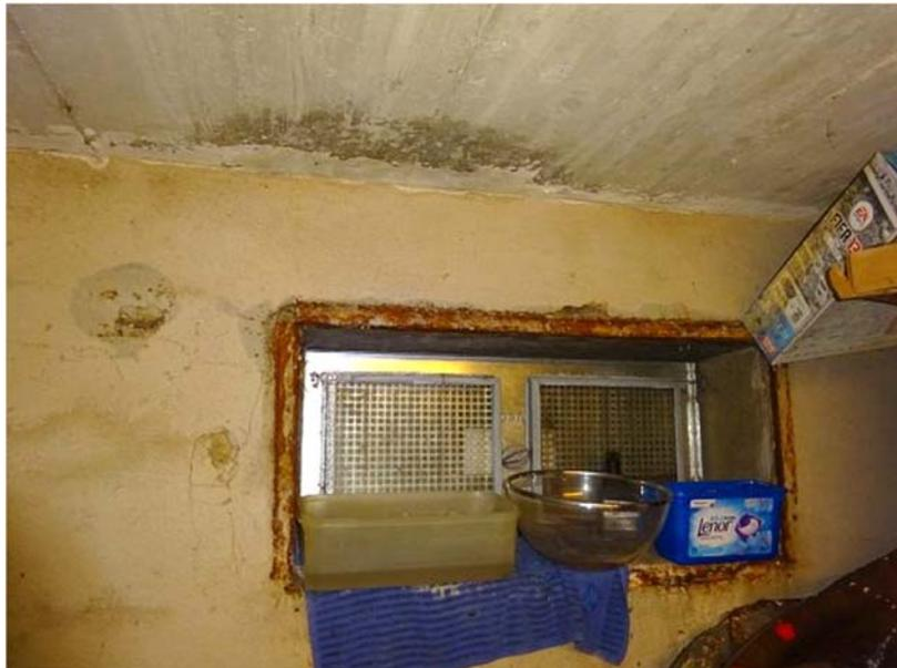
Außenwand und Lichtschacht Front, Feuchteschäden
