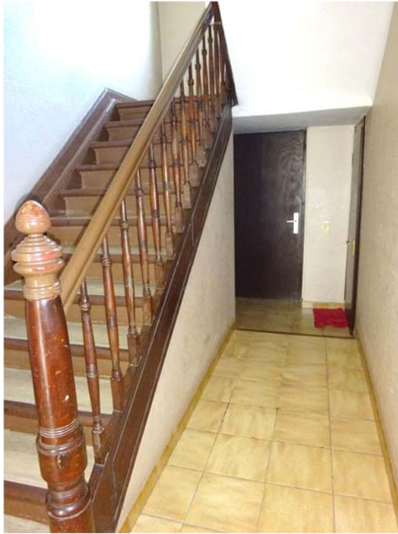
Treppenhaus EG und Zugang Hof
