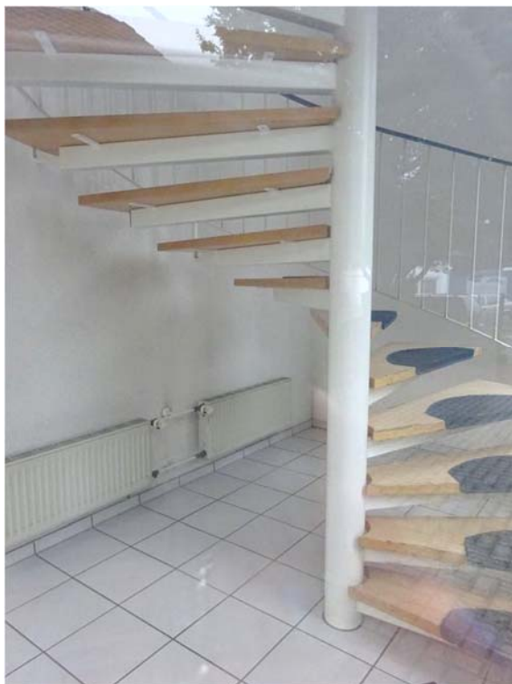
Geschosstreppe / Zugang OG
