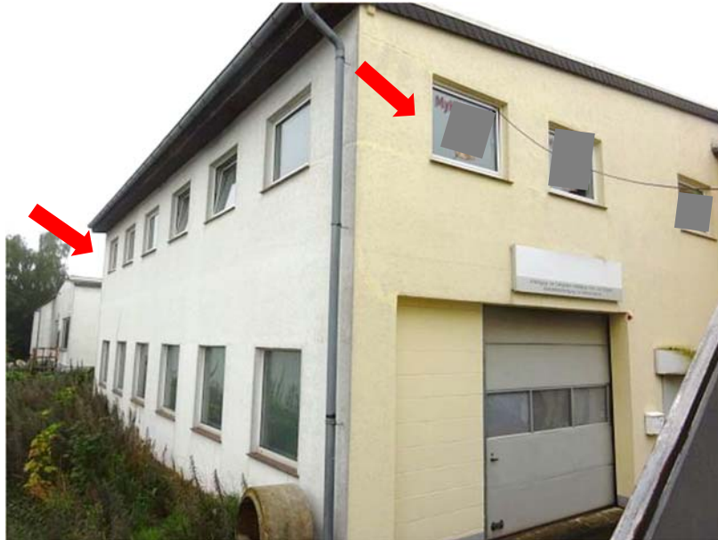
SE Nr. 3 im kompletten Obergeschoss über linkem Hallenbereich
