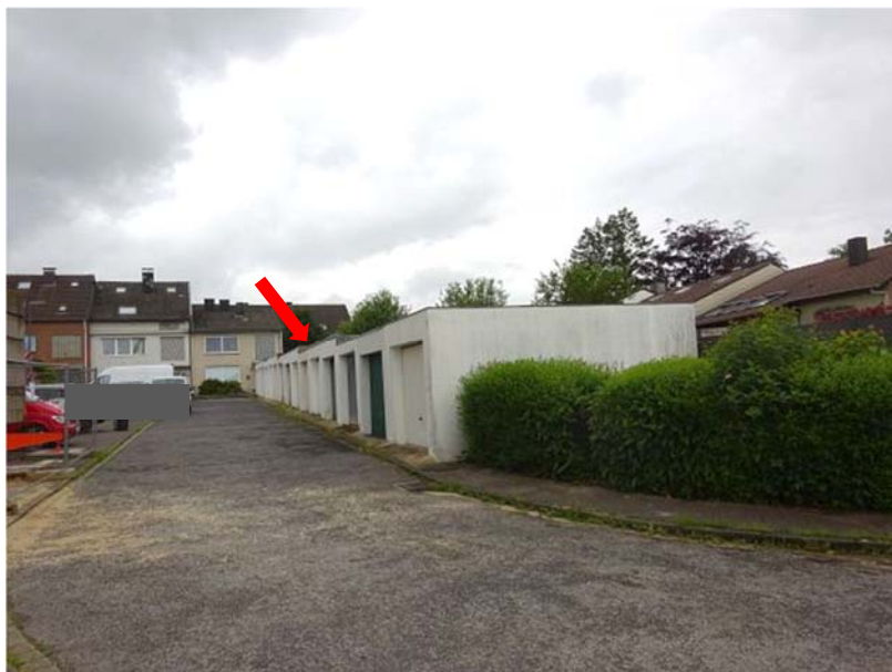
Pfauenweg - Straßenflucht Südwest
