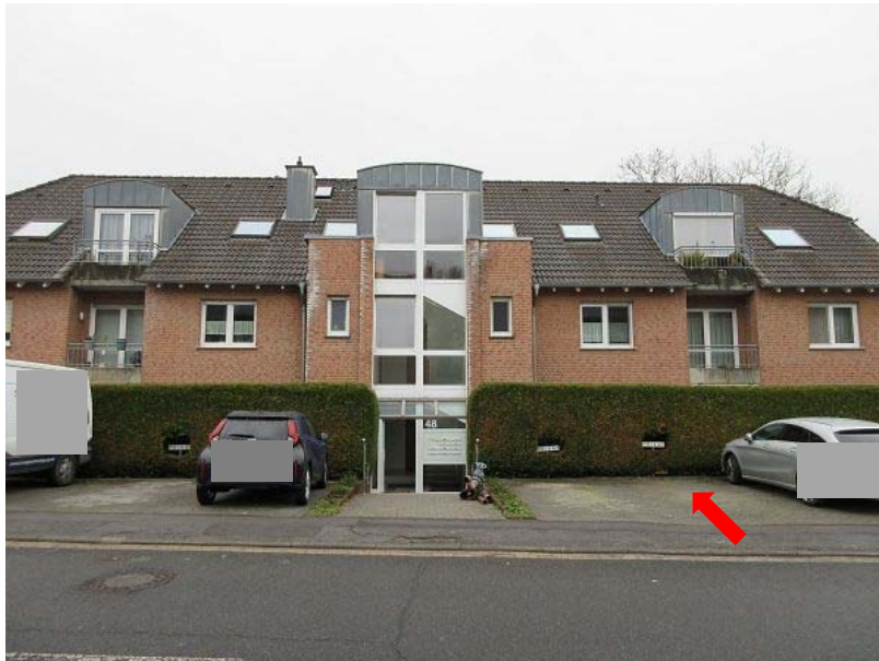
Straßenansicht Werkstraße 48 mit vorgelagerten Stellplätzen Markierung SP Nr. 700
