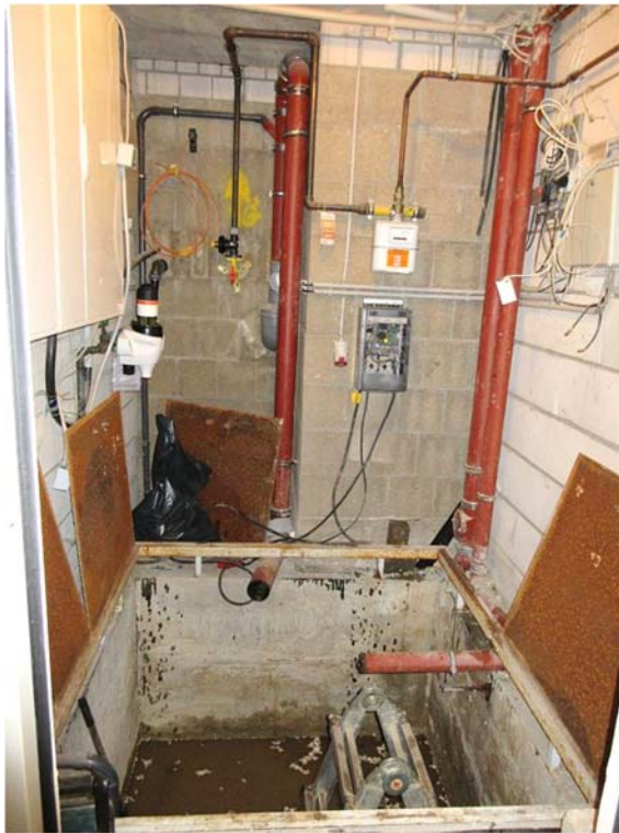
HAR – Erneuerung Hebeanlage
