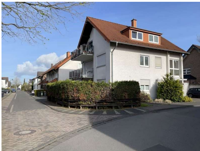
Ansicht von der Ecke Karlstraße / Habsburgerstraße
