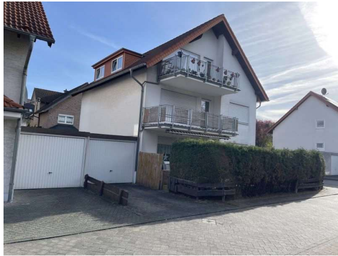
Dreifamilienhaus Habsburgerstr. 30 - Ansicht von der Karlstraße
