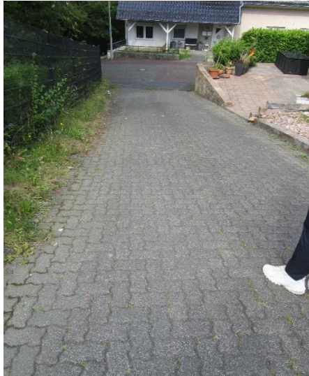
Zufahrt/Weg vom Giesenbachweg zum Objekt
