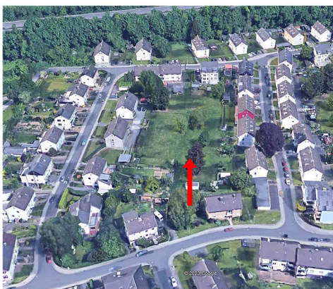
Gesamtansicht von Google Earth
