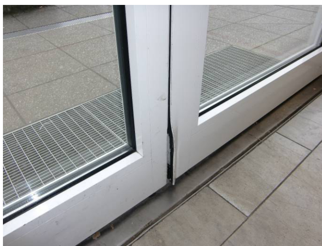
Beschädigte Türanlage
