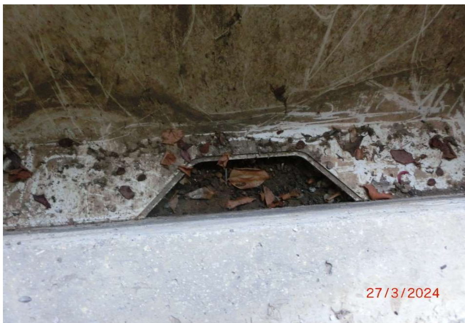
Kellergeschoss und Lichtschacht
