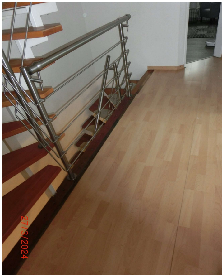
Dachgeschoss und Treppen OG/DG
