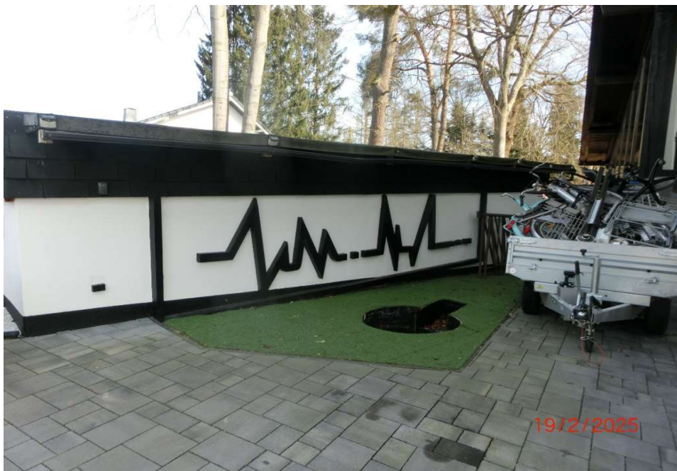
Eingangsbereich und Erdtank/Garage
