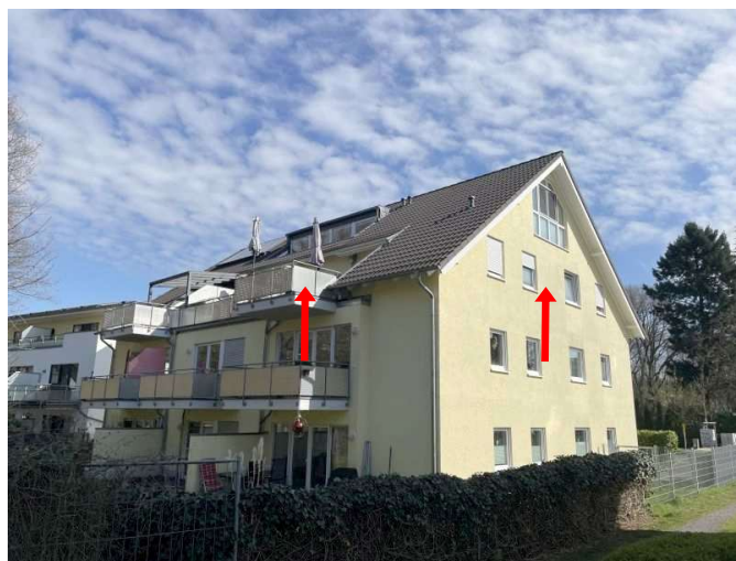
Mehrfamilienhaus Kohlkauler Straße 41 - Südwestansicht
