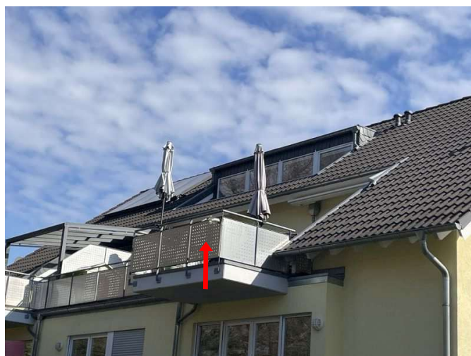
Wohnung Nr. 7 im Dachgeschoss - Westansicht
