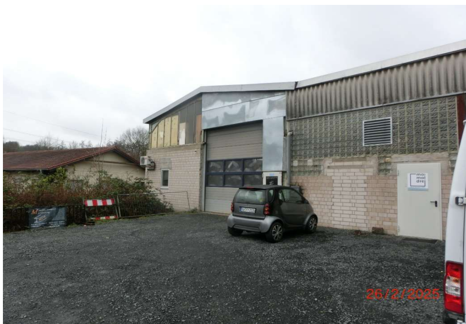
Westansicht und Gebäude 4 und 5
