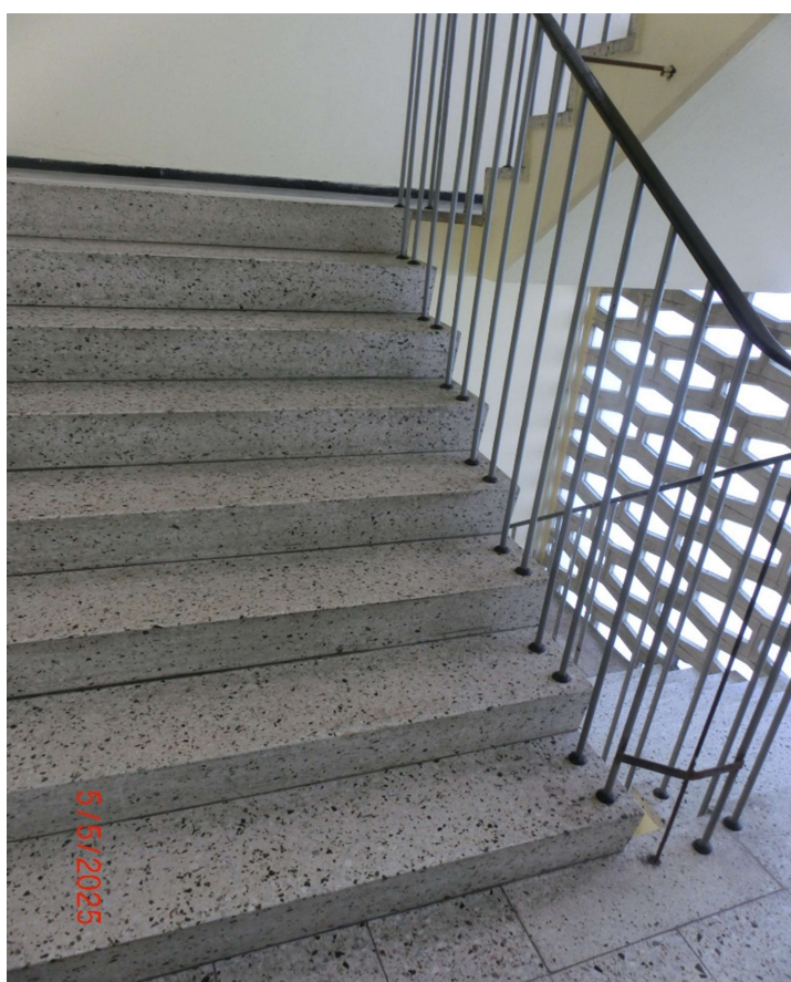
Flur im 7. OG und Treppenhaus
