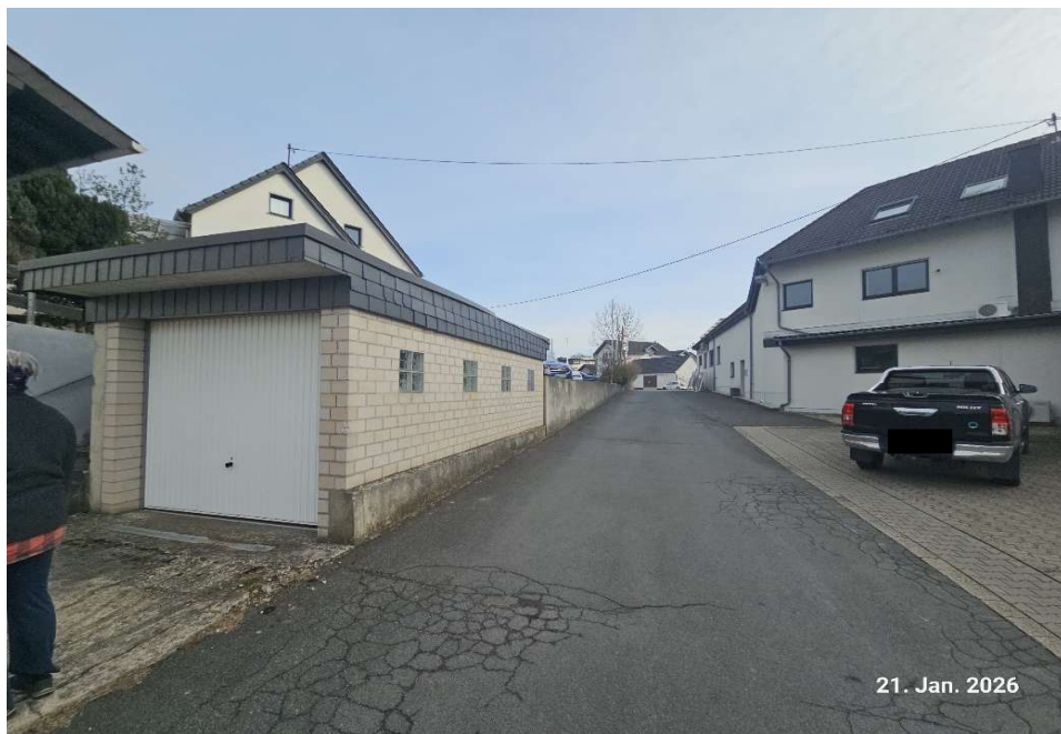
Halle und Einzelgarage
