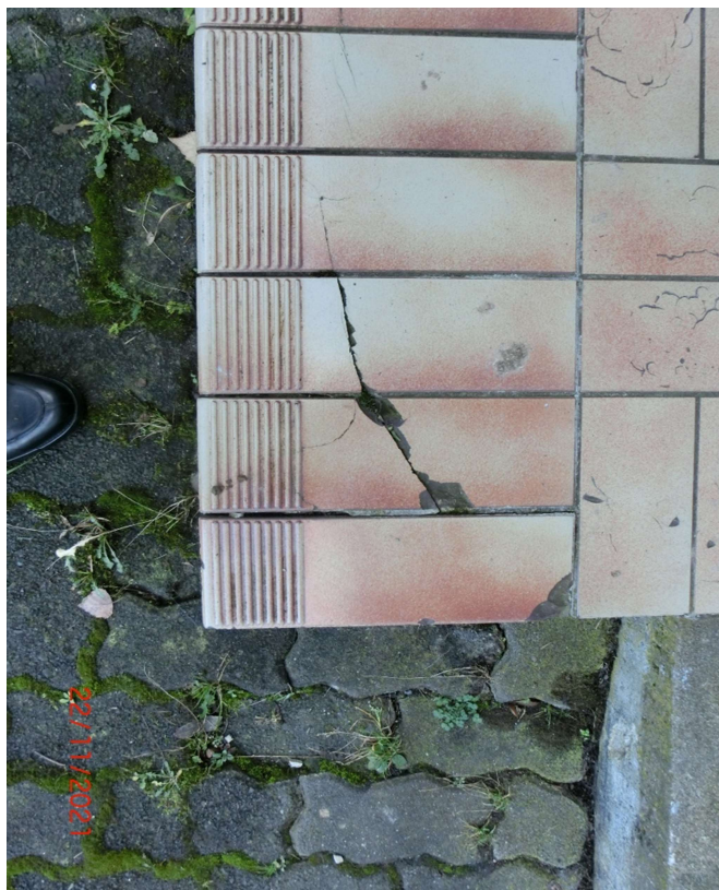
Feuchtigkeit im KG und Rissbildung am Eingangspodest
