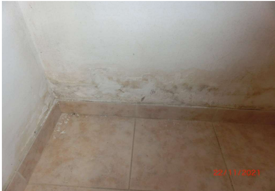
Feuchtigkeit im KG und Rissbildung am Eingangspodest
