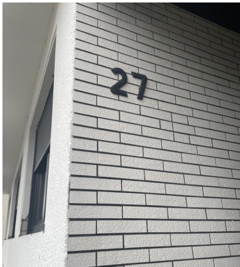
Hausnummer im Bereich der Wohnungseingangstüren
