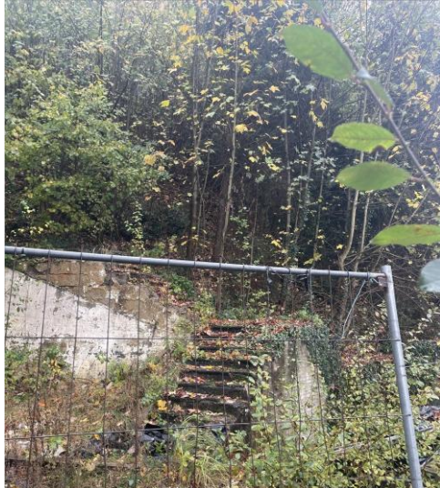
Bereich des zurückgebauten Anbaus
