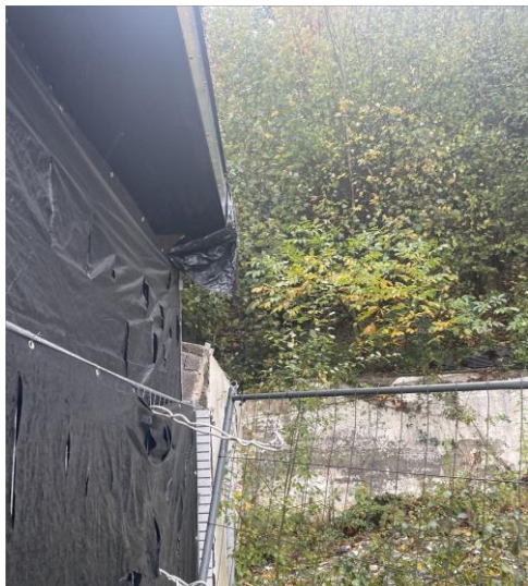
Bereich des zurückgebauten Anbaus
