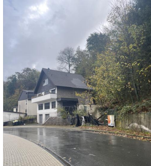
Seitenansicht mit Bereich des zurückgebauten Anbaus
