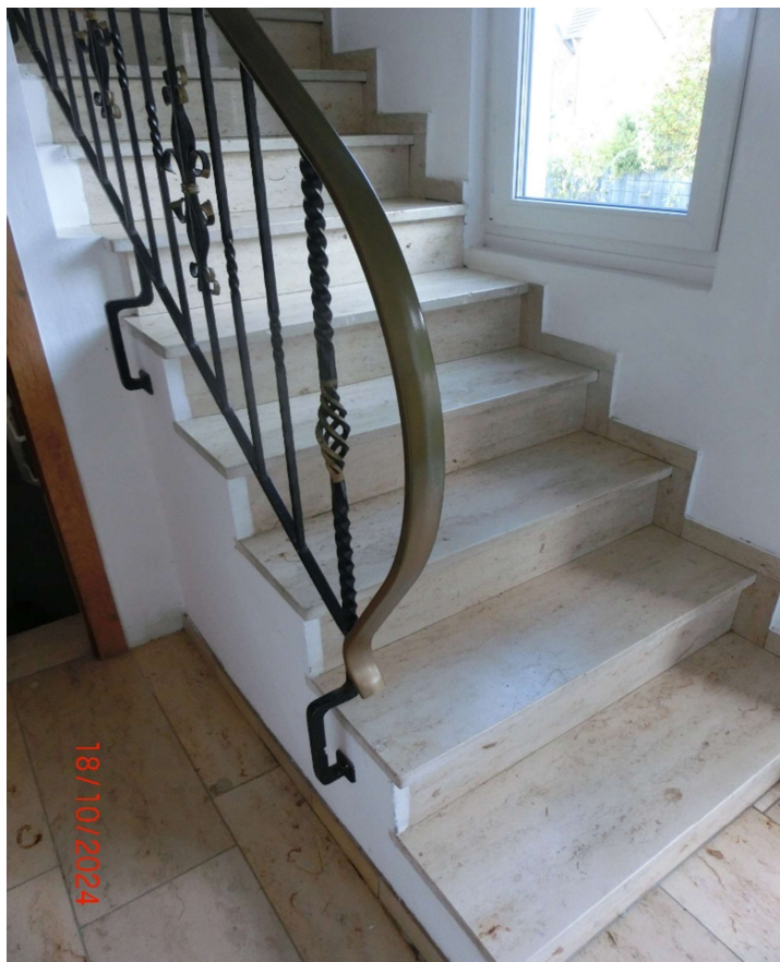
DG und Treppenhaus
