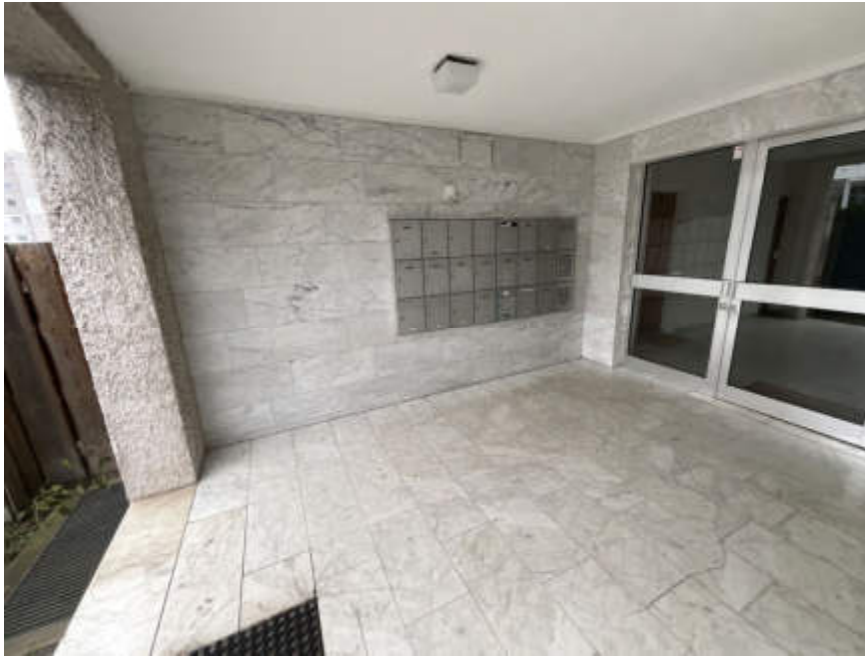
5) Hauseingangstür Haus Nr. 55 / Briefkastenanlage
