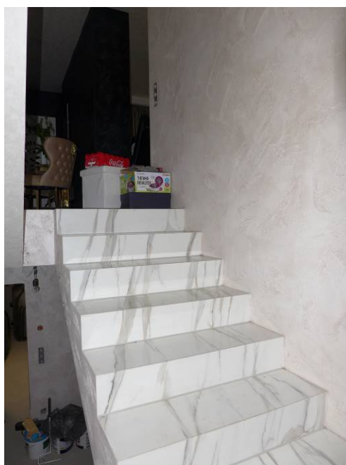
Treppe zum EG (ohne Geländer)
