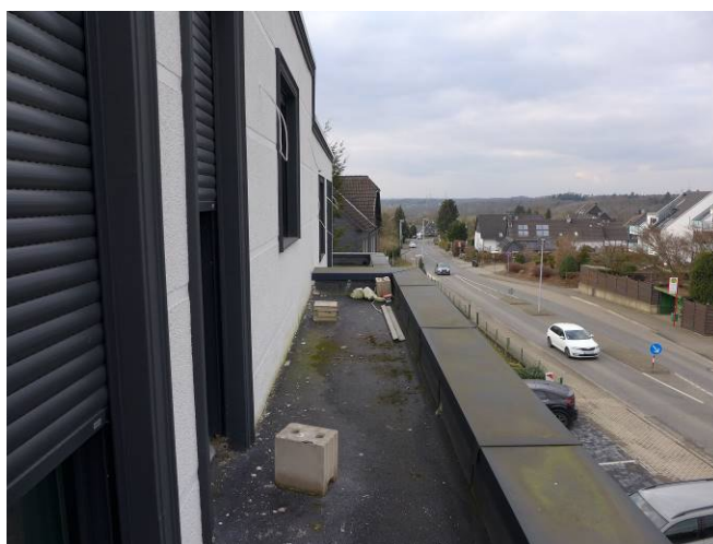
Flachdach OG Straßenseite
