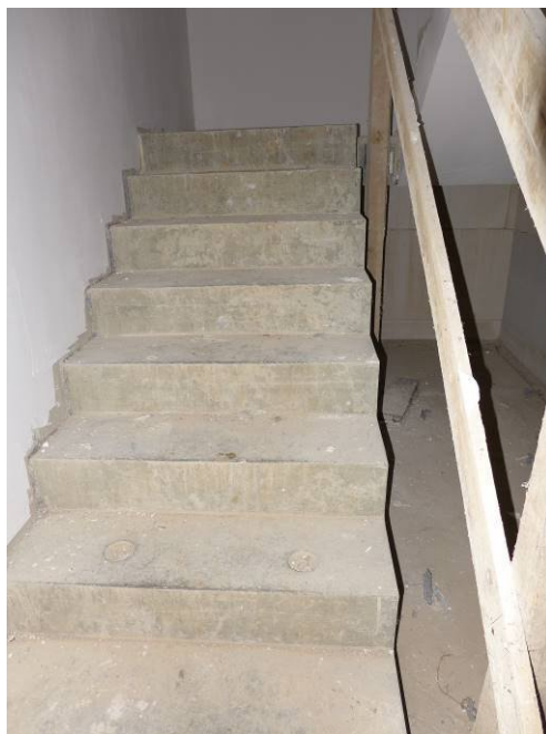
Treppenläufe (Rohbeton)
