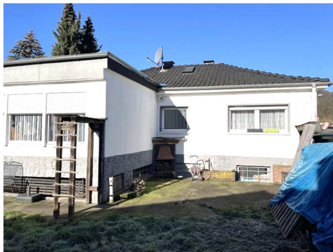
Rückwärtige Ansicht mit Anbau
