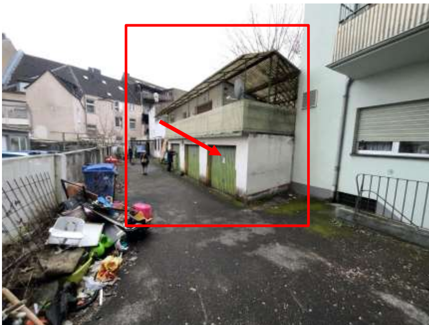
2) Nordostansicht, Hofansicht Anbau mit Garagen
