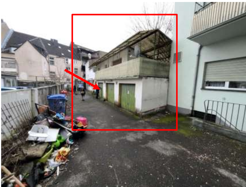
2) Nordostansicht, Hofansicht Anbau mit Garagen
