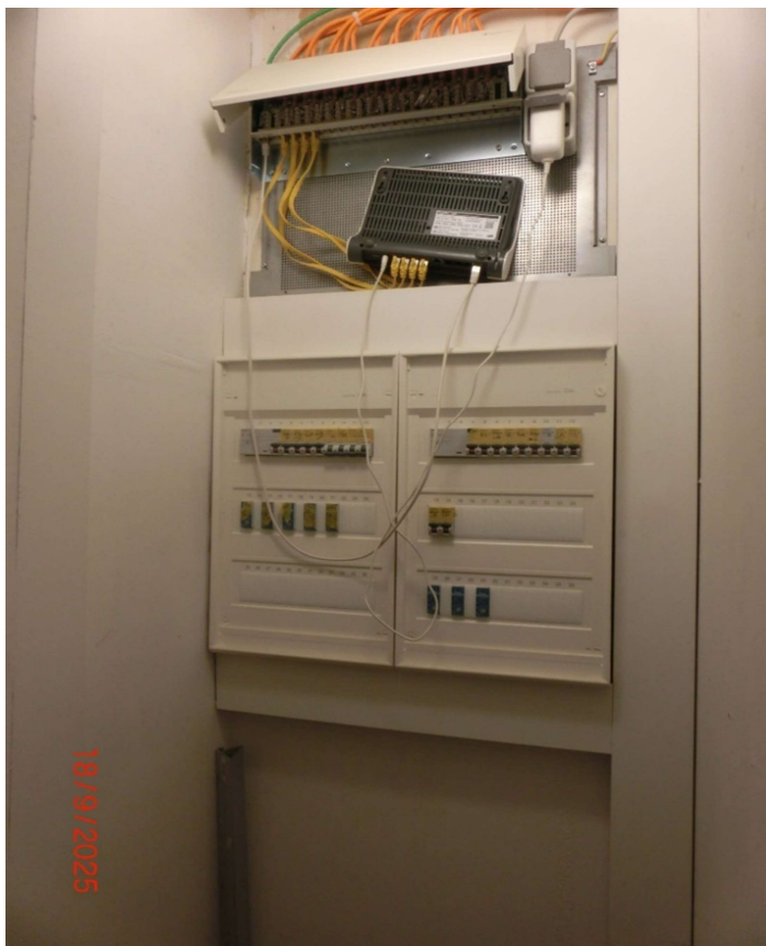
Heizzentrale; Elektrounterverteilung
