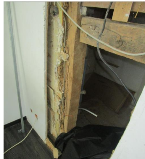
nicht fertiggestellter Raum Obergeschoss
