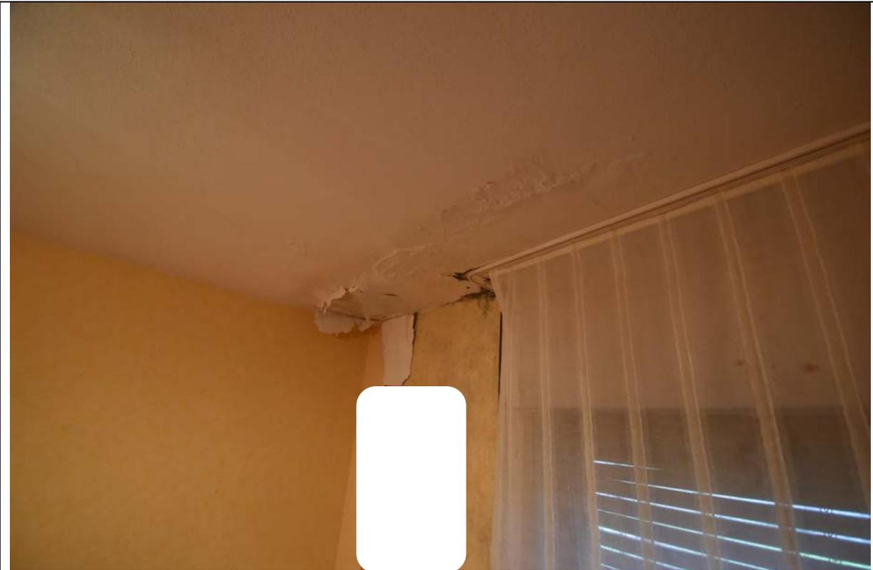
Bild 9 Wohnraum im Obergeschoss mit Feuchtigkeit Decke und Wand sowie daraus resultierendem starken Schimmelbefall
