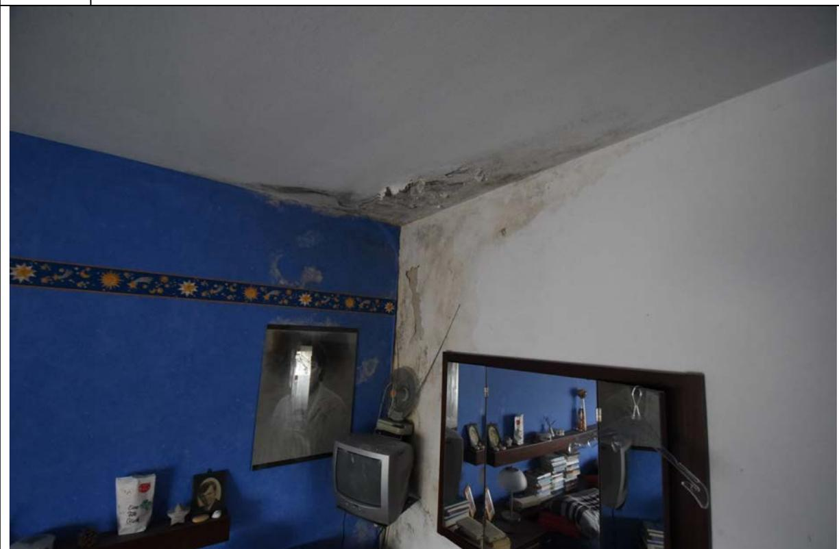
Bild 8 Wohnraum im Obergeschoss mit Feuchtigkeit Decke und Wand sowie daraus resultierendem starkem Schimmelbefall
