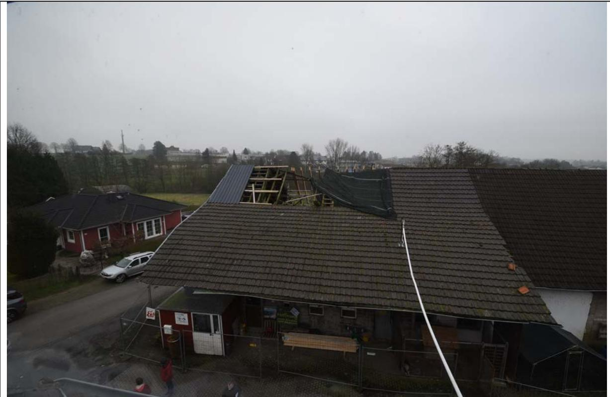
Bild 11 Blick aus dem Wohnhaus auf das gegenüberliegende Wirtschaftsgebäude mit stark geschädigtem Dach und einsturzgefährdetem Dachstuhl
