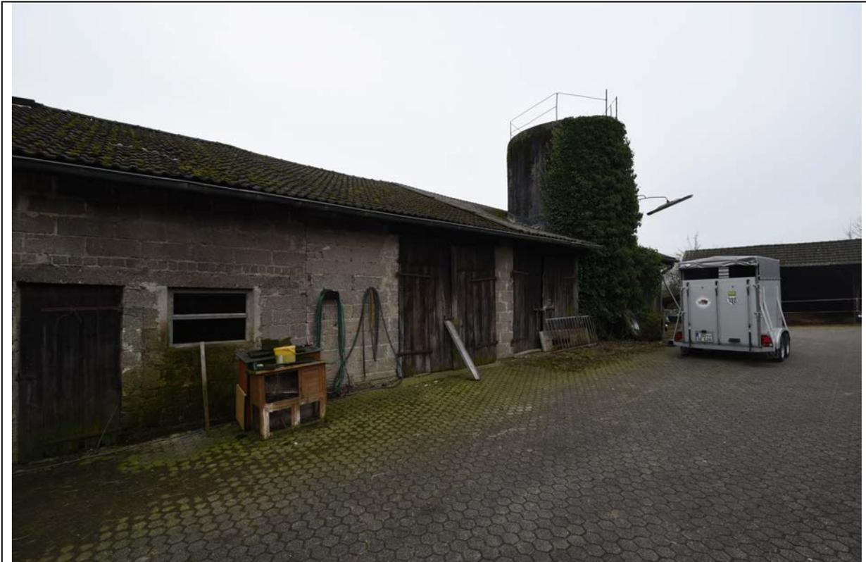
Bild 15 Blick auf die Wirtschaftsgebäude (ehemaliger Schweinestall) mit geschädigten Toren und Türen und starkem Moosbefall der befestigten Fläche sowie Grünbewuchs des nicht mehr genutzten Betonsilos für Grassilage
